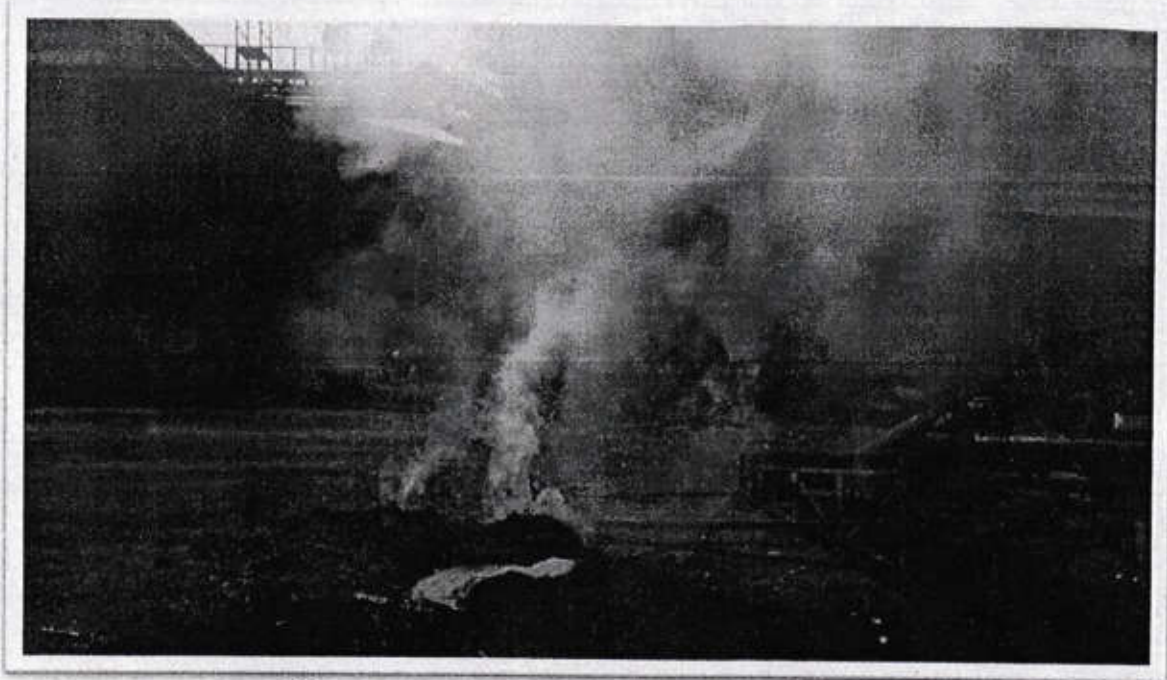
कटींगचे काम करत असतांना लागलेली आग
